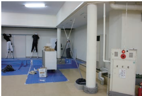
■写真H(10号館)
